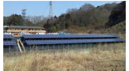
3号機 小瀬保健福祉ゾーン1 2016.3完成
