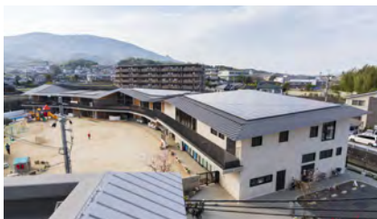
2号機 南こども園 2016.3完成
