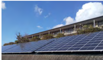
5号機 小瀬保健福祉ゾーン2 2021.11完成
